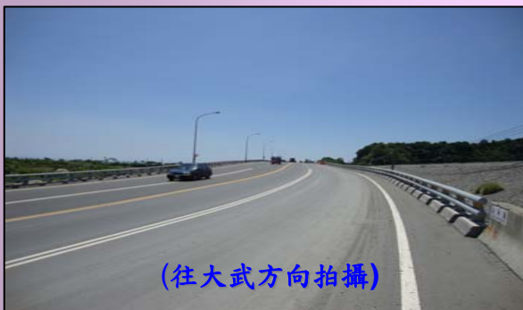
(南太麻里橋全景)
