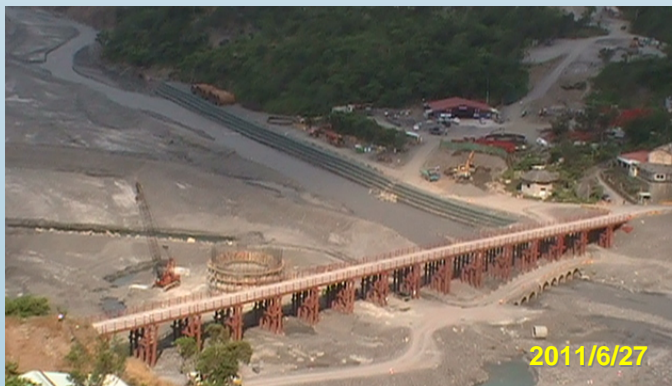
第一號橋(伊拉橋)施工情形
